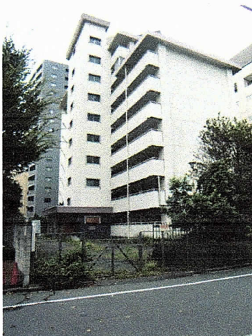
解体する旧公務員宿舎 正面
