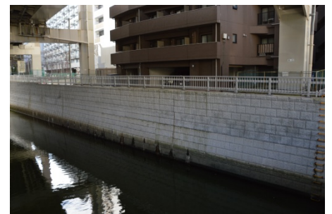
施工例(麻布一之橋)
