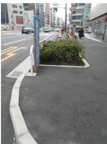
植栽の幅分、歩道を広げた
