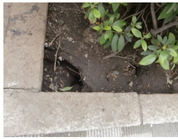
中央通り外神田歩道（都道）
